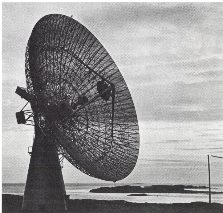
Fig. 6. Radioteleskop ved Onsala radio-observatorium nær Göteborg. Diameteren af det drejelige og styrbare metalspejl er 25 meter.
